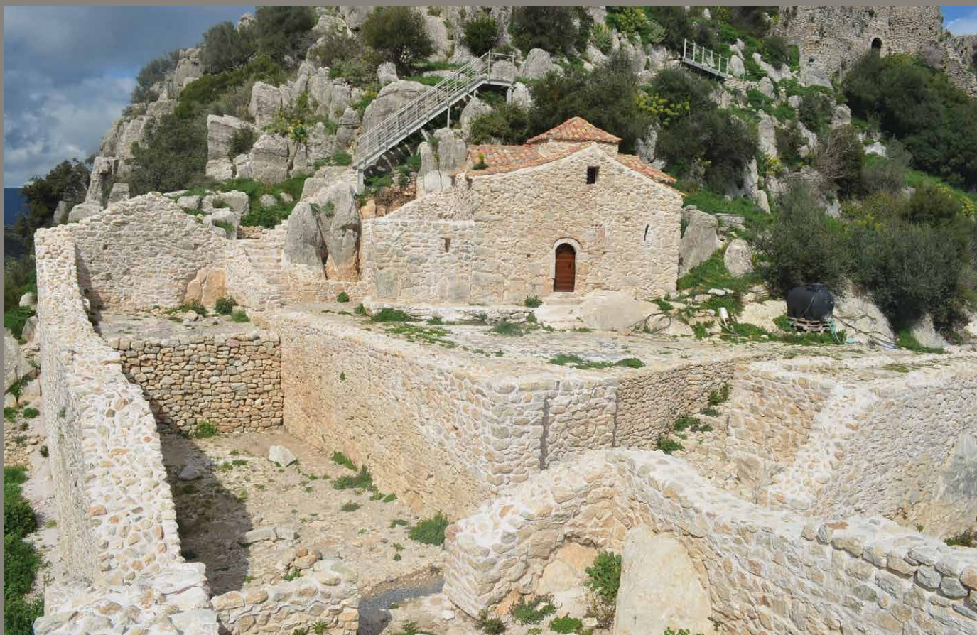
Η πτέρυγα Β, πριν, κατά τη διάρκεια και μετά το πέρας των εργασιών Wing B, before, during and after the restoration works
