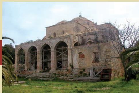
Το προστώο κατά την διάρκεια των εργασιών αποκατάστασης View of the portico during the restoration
